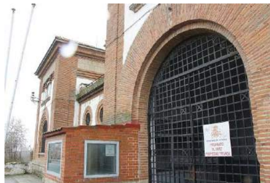
Fachada principal de la cárcel vieja de Héroes de Baler Fuente (Hoy.es 30 enero 2016)
