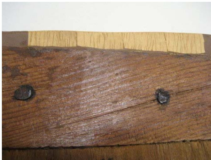
Injertos en las lagunas de la madera de cubierta
