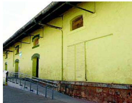
Nave de Renfe en la que se están haciendo los trabajos provisionales de recuperación. Foto:R. HABA
