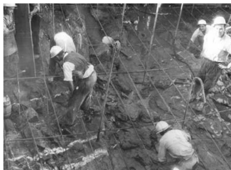
Fig. 24. Salto de Torrejón: Trabajos de cimentación Bloque I (1962)
