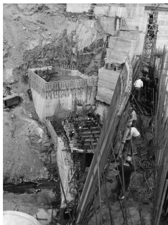
Fig. 27. Salto de Cedillo: hormigonado del bloque I (1970)
