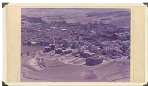
Fig. 12. Vista aérea de La Madrija (Cáceres) ES.10037.ADPCC / 04.02.50.02. // FOT 00062
