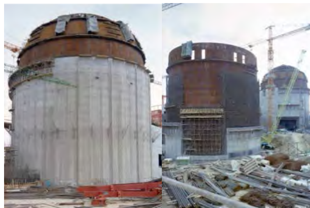
Fig. 26 y 27. Construcción de la central nuclear de Almaraz. Fondo Cristóbal Portillo. 1975. ARCM. Signatura 84129
