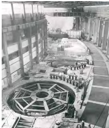
Fig. 28. Valdecañas: Montaje maquinaria de la central (1963)
