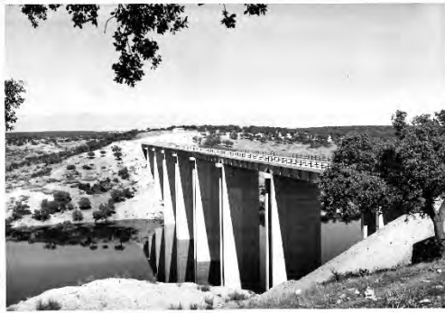
Fig. 29. Puente de Alarza (1964)
